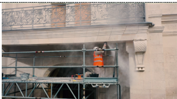
Harmoniser la façade à l'eau de chaux
