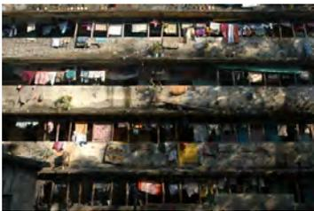
Les matériaux de construction de qualité médiocre ont été rapidement altérés par la mousson. Les coursives ont dû être systématiquement renforcées par des étais de bois.
