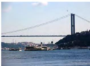
Le pont du Bosphore, parfois appelé pont "Atatürk" a été en son temps le témoignage d'une prouesse technique : plus d'un kilomètre d'une voie suspendue à 64 mètres au dessus de l'eau, sépare les deux tours.
