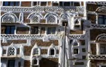
Le mortier utilisé pour le contour des fenêtres et les extrémités des poutres dessine de subtiles arabesques.
