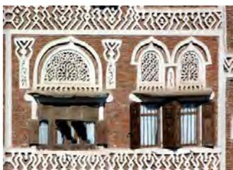
Des percées à volets en bois permettent la circulation de l'air et de la lumière. Quand ils sont fermés, les oculi d'albâtre et les petites ouvertures verticales de chaque côté de la fenêtre pallient ces besoins.
