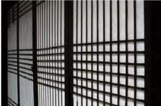
Les cloisons, faites d'une structure en bois recouverte de papier de chaque côté, permettent d'isoler correctement la pièce tout en laissant passer la lumière. Les motifs symétriques sont toujours préférés.
