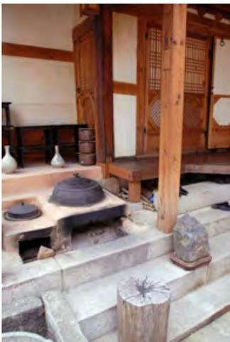
Le système de chauffage par le sol, le *ondol*, se compose d'une fournaise et de conduits placés sous la maison et dans lesquels circule l'air chaud. Les Coréens peuvent ainsi s'asseoir confortablement, à même le sol.
